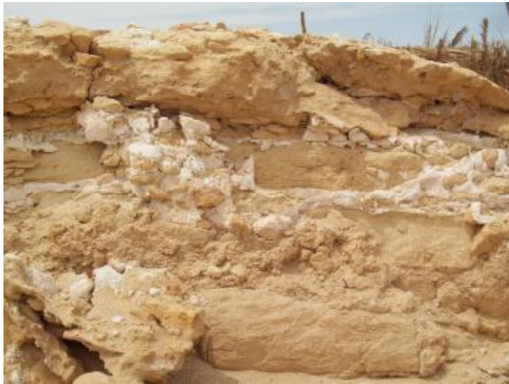
صورة (٧) توضح مظاهر تلف مختلفة نتيجة تكامل الظروف البيئية المحيطة بأطلال المعبد ووجود الشروخ المتعددة نتيجة للأجهادات الداخلية وعمليات التمدد والأنكماش للبلورات الملحية
