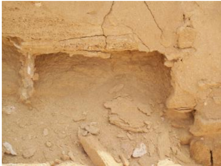
صورة (٦) توضح ظاهرة نضيف الحجر نتيجة تغيرات درجة الحرارة والرطوبة نتيجة المناخ الصحراوي الواقع به المعبد الدوري
