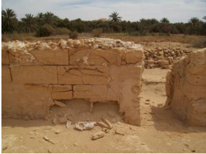
صورة (٧) توضح مظاهر تلف مختلفة نتيجة تكامل الظروف البيئية المحيطة بأطلال المعبد ووجود الشروخ المتعددة نتيجة للأجهادات الداخلية وعمليات التمدد والأنكماش للبلورات الملحية
