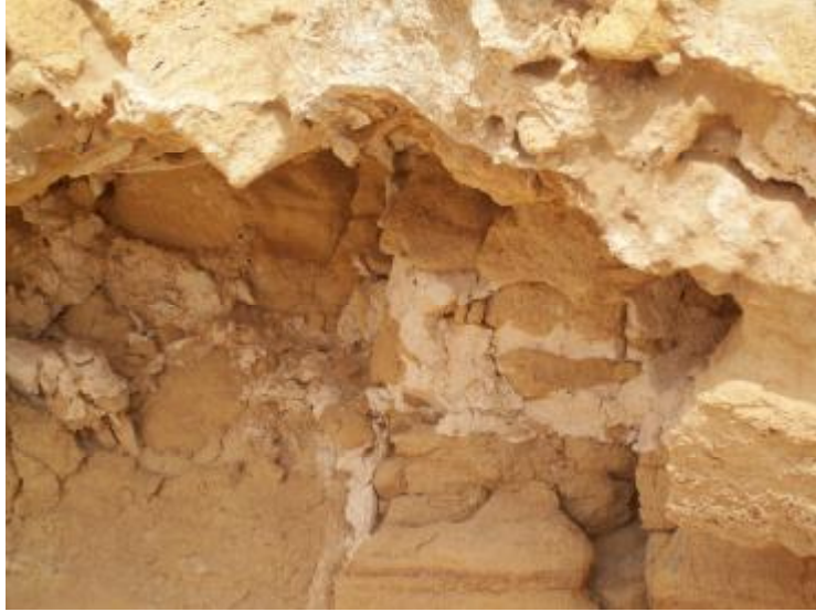
صورة (٥) توضح تحطم أطلال المعبد تحت مخلفات الأتربة والرمال المتراكمة وعمليات تبلور الأملاح خلالها وأهمها معدن الهاليت والجبس والأنهيدريت
